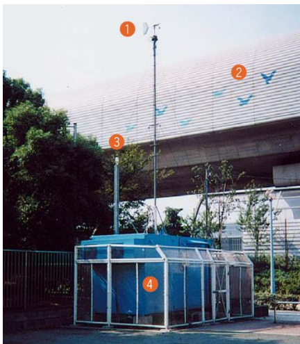
高速自動車道脇に設置されている、騒音・大気測定器格納施設
